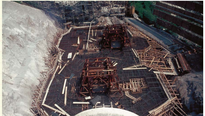
Blick auf die Baustelle des Hauptzuganges Trozzenberg in Marienthal mit den beiden eingesetzten MAN-Toren.
