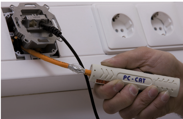
Bild 6: Anwendung eines Abmantelwerkzeugs (Jokari) a) bei einer Mantelleitung in einer Hohlraumgerätedose b) bei einer Datenleitung
